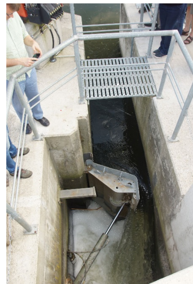
Bypass am Standort Halle-Planena/Saale über den Gesamt Gewässerquerschnitt zur Ableitung von Schwemmgut
