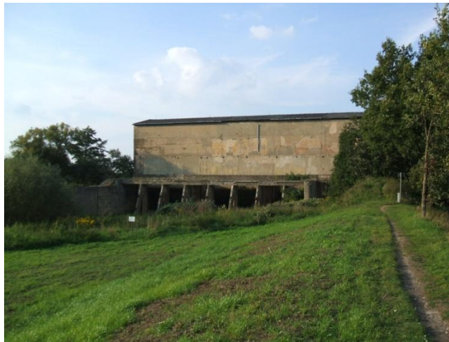
Abb. 3-1: Altes Wasserkraftwerk bei Canitz
