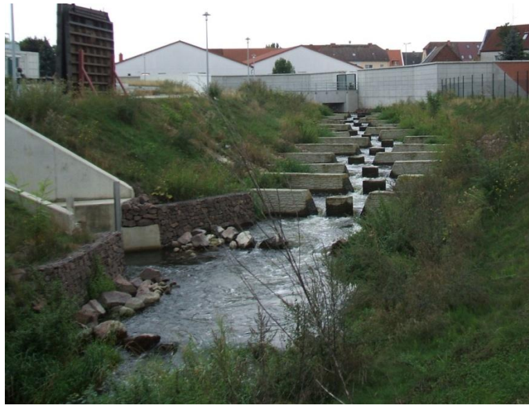
Abb. 6-2: Fischaufstieg der Wasserkraftanlage am Wehr Raguhn
