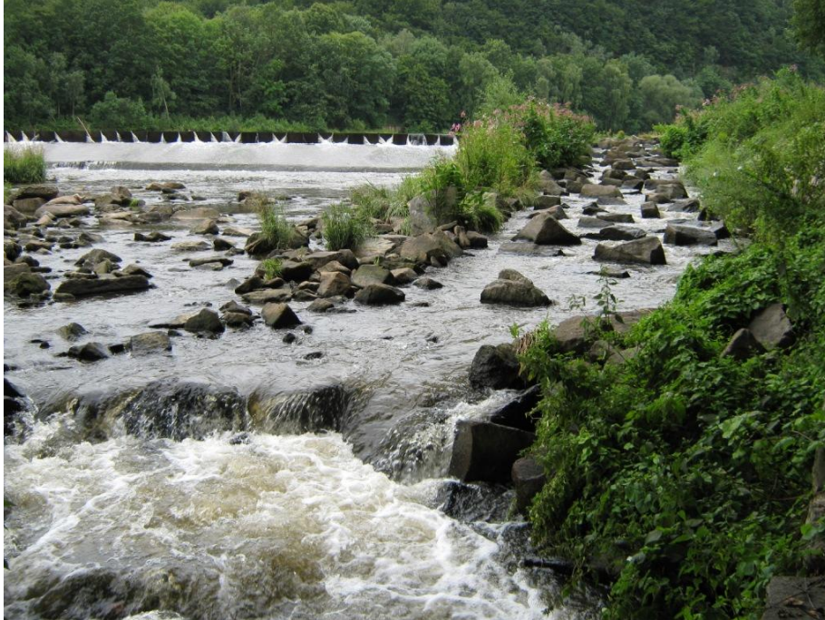
Abb. 6-7: Aufnahme der Fischrampe in Golzern (Kerle, 22.07.2009)
