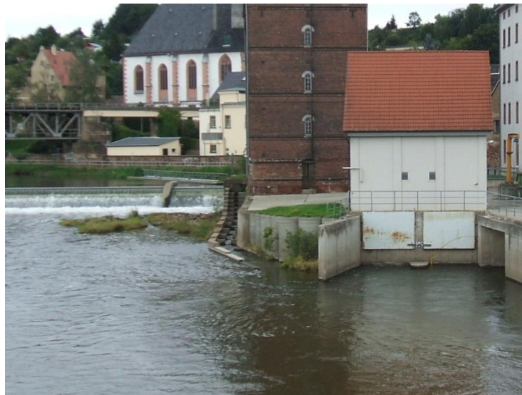
Abb. 6-12: Fischpass zwischen Wehr und WKA in Rochlitz
