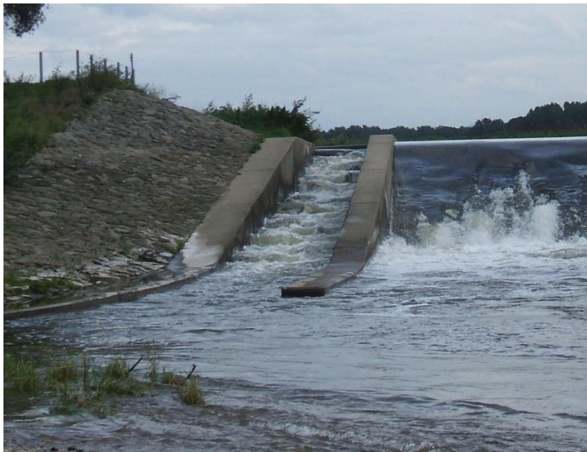
Abb. 6-5: Fischpass an der Wehranlage Kollau
