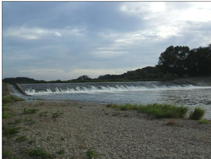
Abb. 5-3: Wehr Kollau, Vereinigte Mulde
