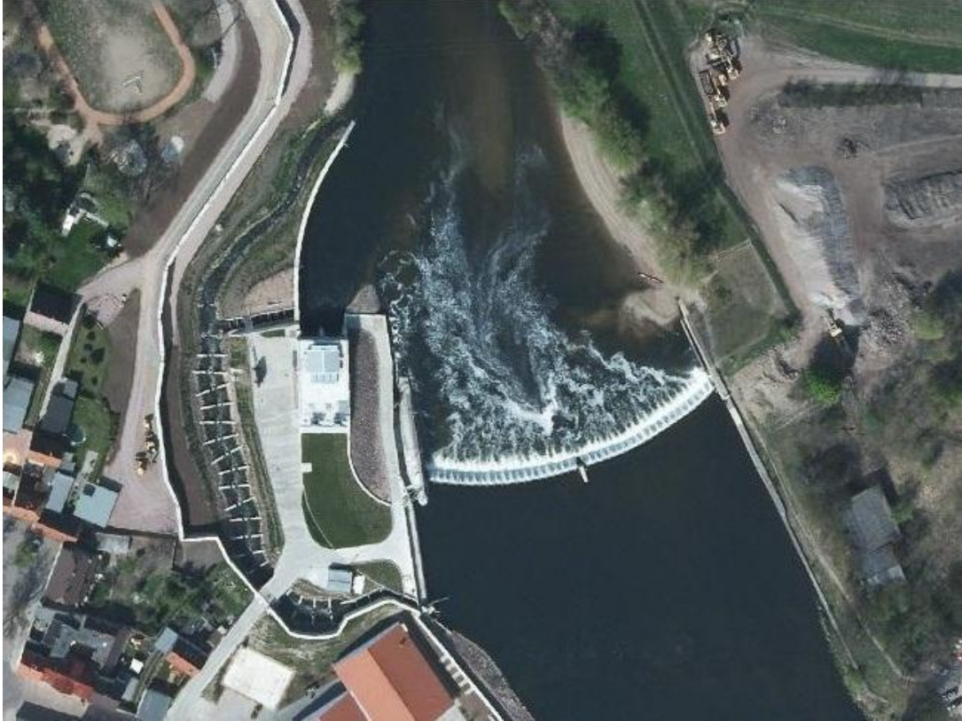
Abb. 6-3: Wehr und Kraftwerk Raguhn (aus „Geoview“)
