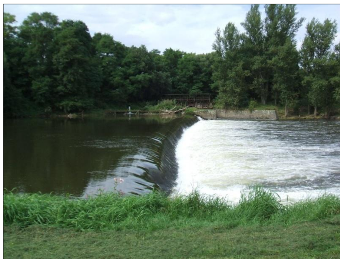
Abb. 5-4: Wehr in Pauschwitz zur Brauchwasserentnahme, Vereinigte Mulde
